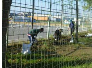
側溝の泥上げ作業
